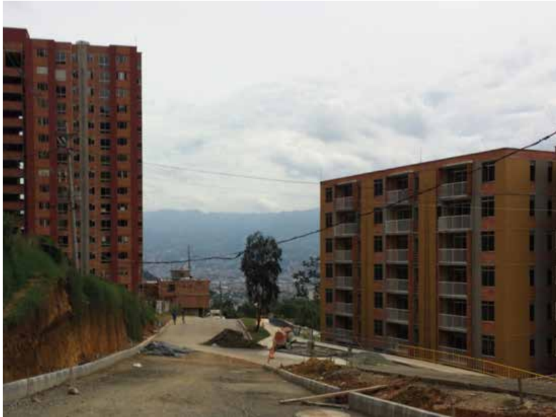
Vivienda en construcción en área de expansión urbana
